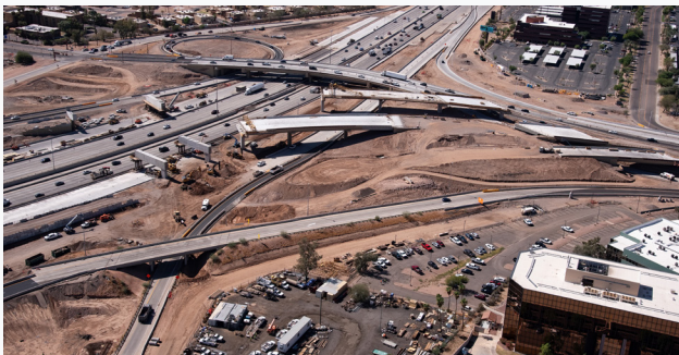
El intercambio de la SR 143 y la I-10 en 2023 cuando cuadrillas estaban construyendo las rampas elevadas.
