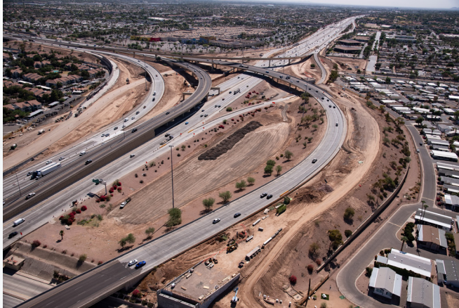
El intercambio de US 60 y la I-10 en 2023 cuando cuadrillas estaban construyendo las carreteras CD.
