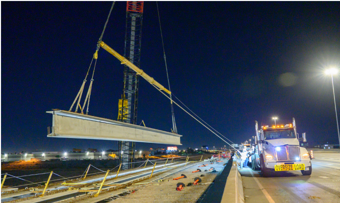
Una grúa levanta una viga desde la I-10 en dirección oeste y la mueve lentamente a su posición sobre las nuevas tapas del puente.
