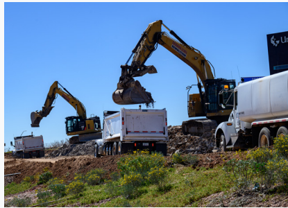
Los excavadores cargan escombros desde la rampa de salida de la I-10 en 32nd Street a camiones volquete para ser llevado.
