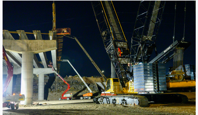
Una vez colocada la viga, cuadrillas se aseguran de que esté estable y segura antes de desconectarla de la grúa.
